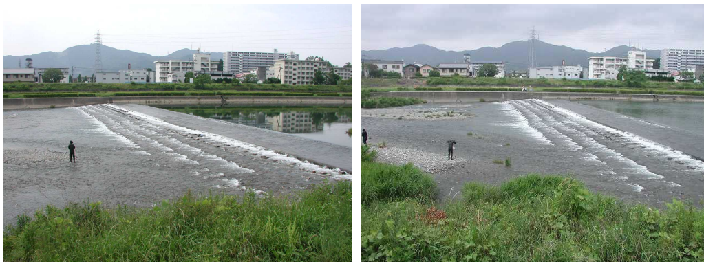
トリム公園床止 (St.2) の調査時の状況 (左:平成 18 年、右:平成 20 年)
