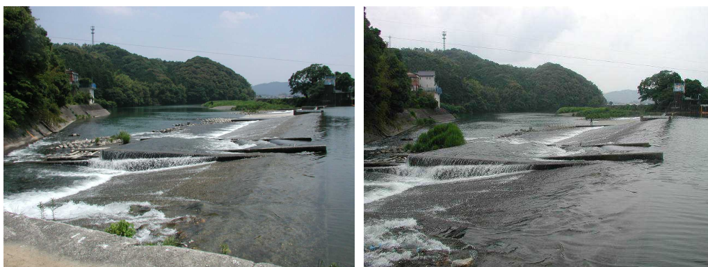
調査時における朝倉堰の流況(左:平成 18 年、右:平成 20 年)
