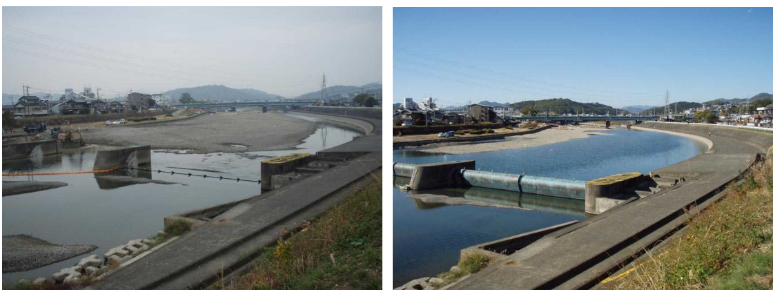
流量調査時の廓中堰の状況（左：平成 19 年 11 月 28 日、右：平成 19 年 11 月 30 日）
