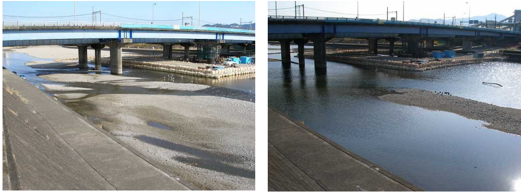
St.4 (左：廓中堰ゲート転倒時、右：ゲート起立時)
