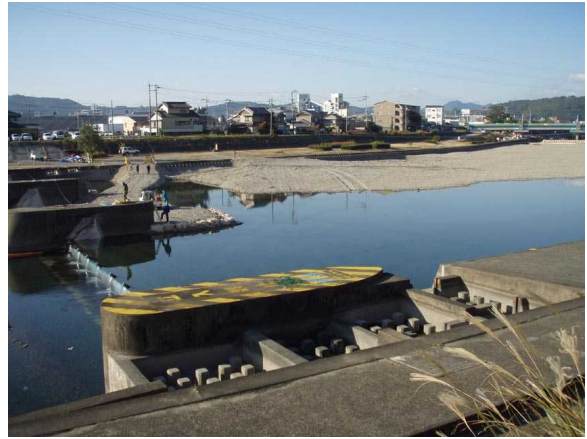
ゲート半開放の状態(平成19年11月22日)、ゲートがやや起立し、湛水域が広がっている。
