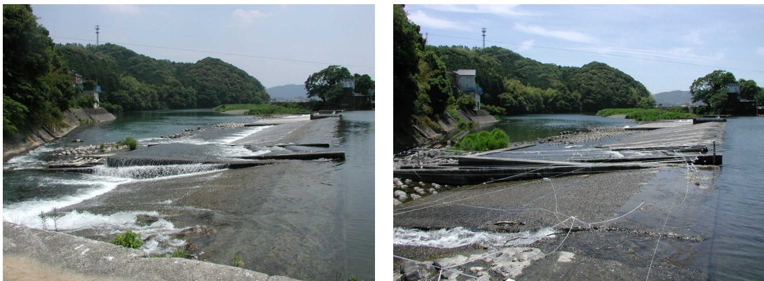
調査時における朝倉堰の流況（左：平成 18 年、右：平成 19 年）
