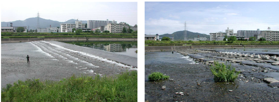
調査時におけるトリム公園地先床止の流況（左：平成 18 年、右：平成 19 年）
