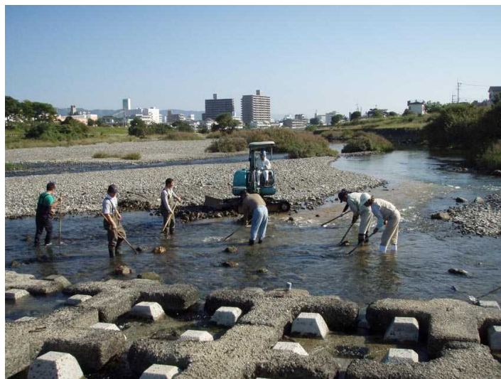
トリム公園床止直下でのアユ産卵場の整備状況(平成19年10月28日)。小型バックホウと人力により河床を耕うんし、堆積した泥を洗い流した。
