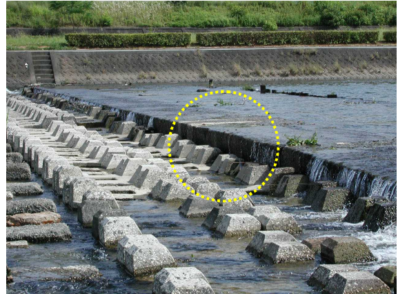
堤体と護床工との段差の状況(平成19年5月28日)
