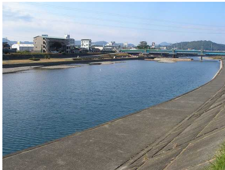
廓中堰湛水域(平成19年11月25日)。廓中堰のゲートは閉鎖されており、湛水域が上流に延伸している。
