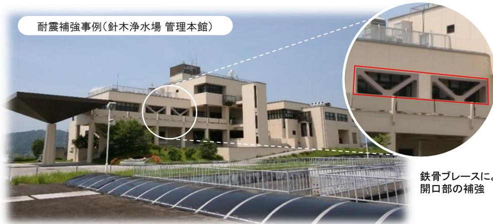
鉄骨ブレースによる開口部の補強
