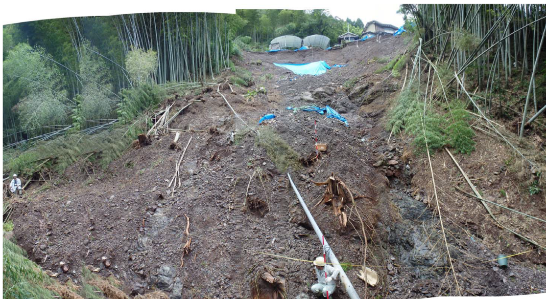
写真 1 高知市土佐山菖蒲地区の土砂災害
