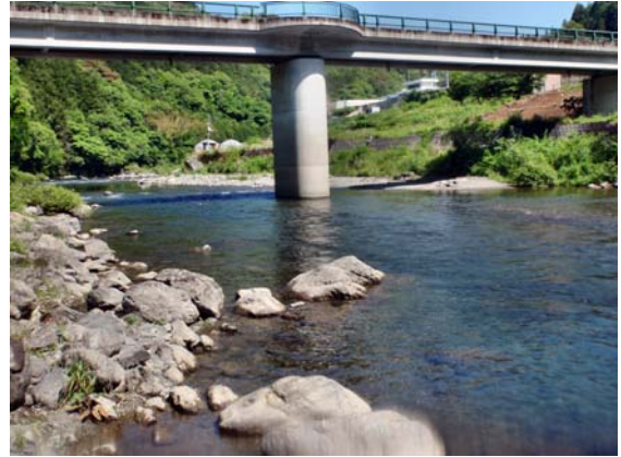
St. 17 (札幌ノ下橋)
