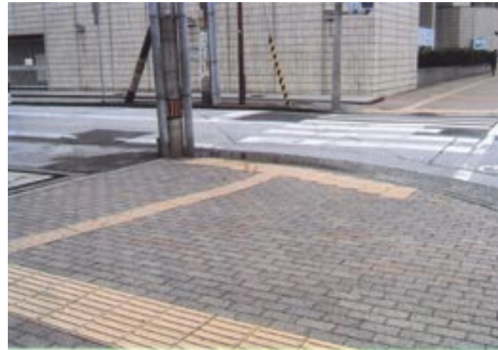
電柱が障害になりブロック配置替
