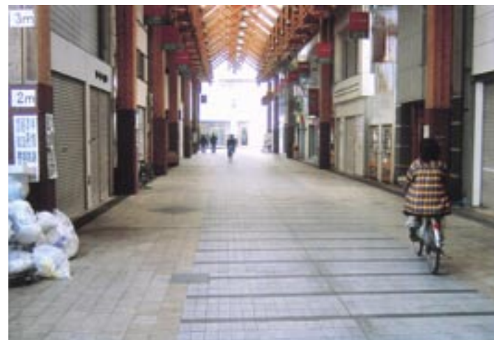
誘導ブロックの新設
