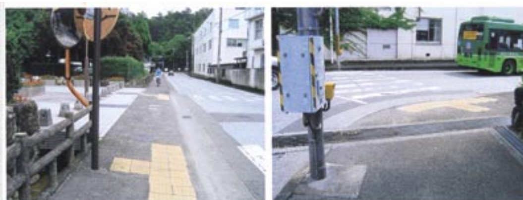
誘導ブロックの新設
