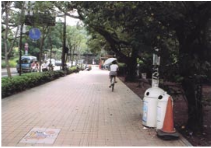
視覚障害者誘導ブロックが同色調につき改良
