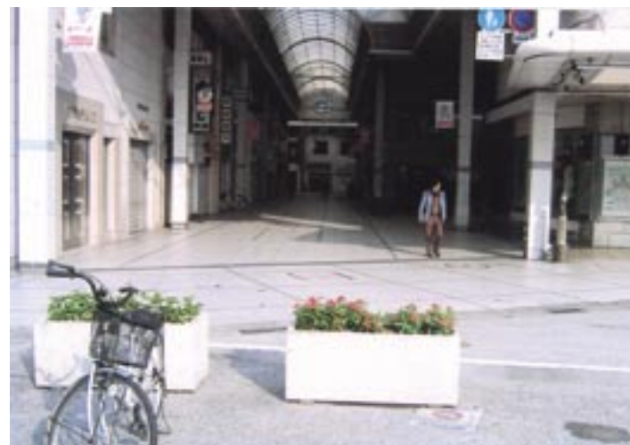
誘導ブロックの新設
