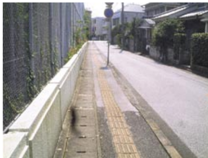
歩道浪打ちで改良
