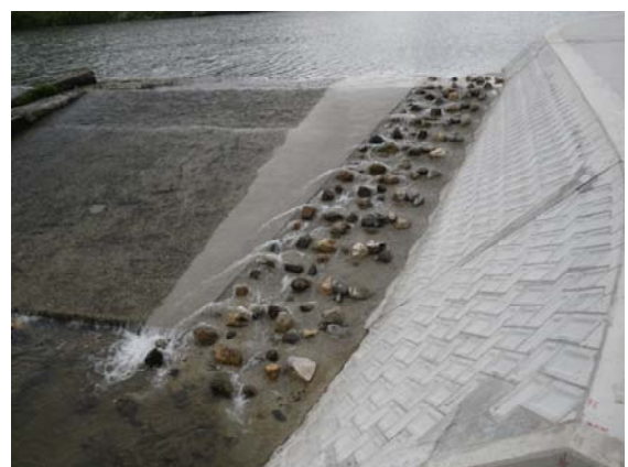
朝倉堰に設置された粗石付き斜路魚道
