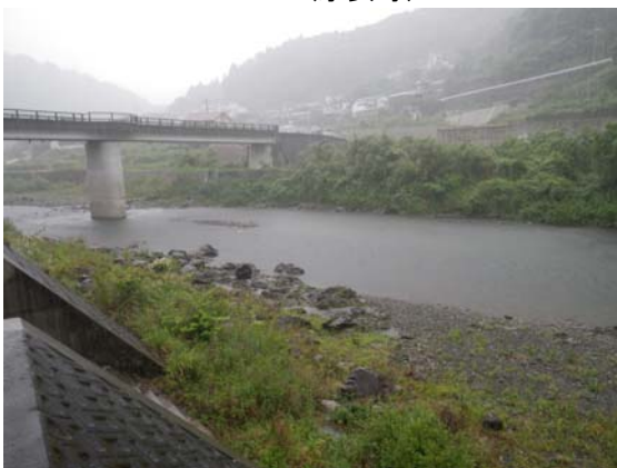
St. 17 (札場ノ下橋)
