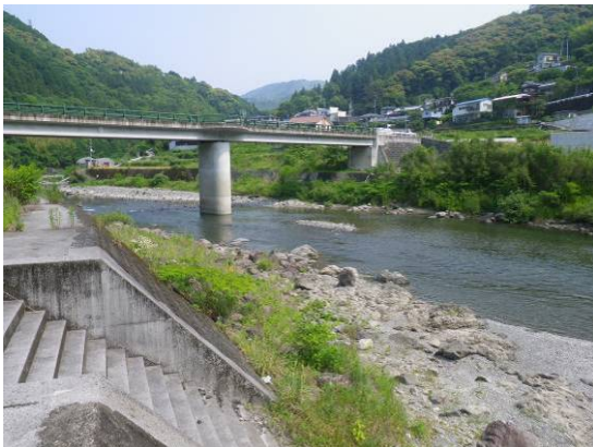
St. 17 (札幌ノ下橋)
