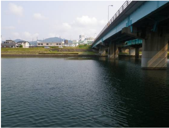
St. 5 (廓中堰湛水下)
