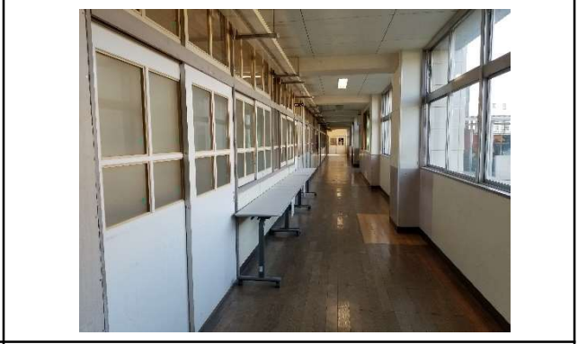
④天井：照明などの落下物がないか確認
