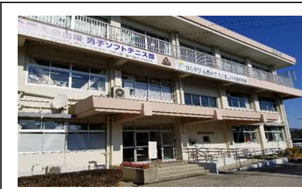
①昇降口：窓ガラスに割れはないか確認
