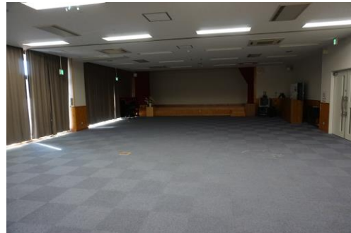
④天井：照明などの落下物がないか確認
