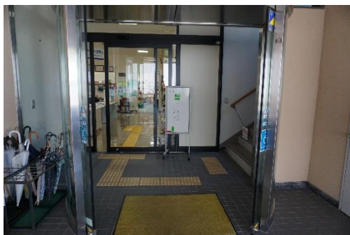
①入口：窓ガラスに割れはないか確認
