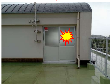
屋上の屋内入口
