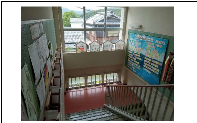
①壁の落下、窓ガラスの割れはないか確認
