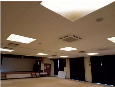
②天井：照明などの落下物がないか確認
