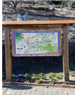
史跡紹介掲示板の修繕
