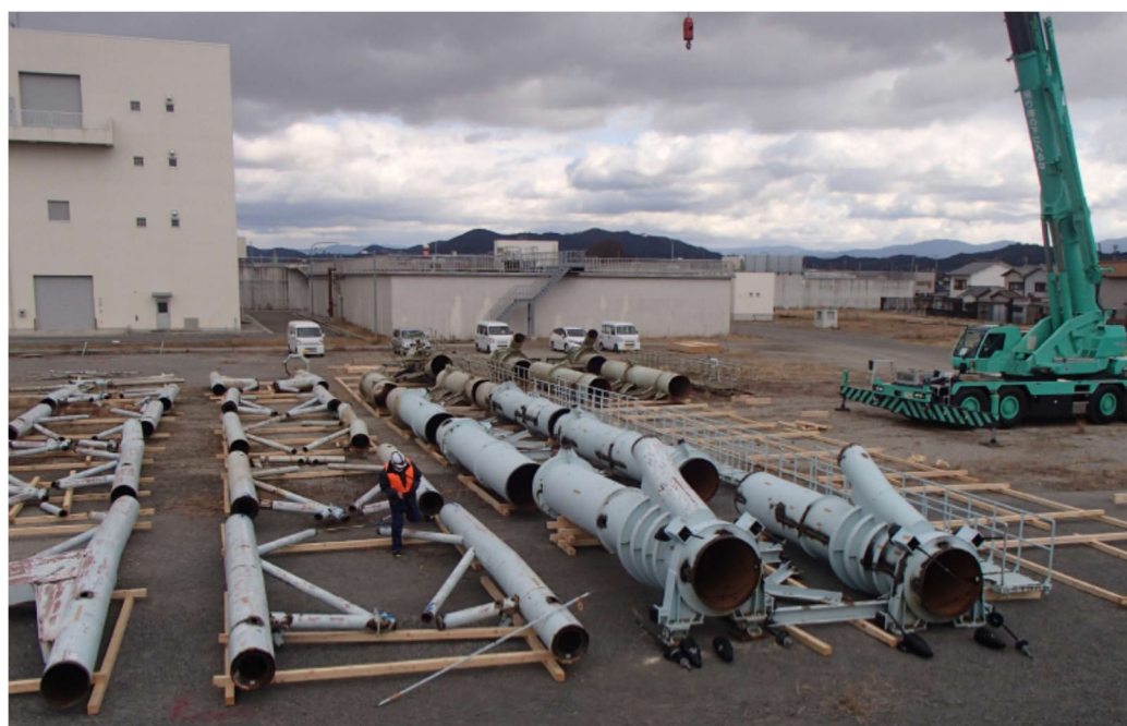
（回収した落橋水管橋の仮置き状況）
