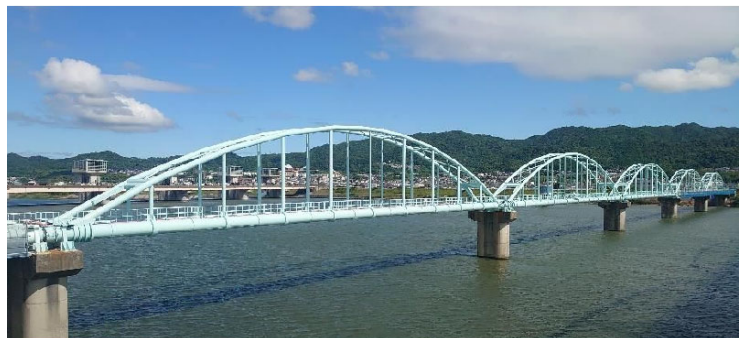
〔塗装塗替えによる修繕〕
