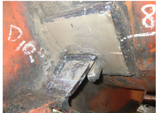
〔板溶接による修繕〕
