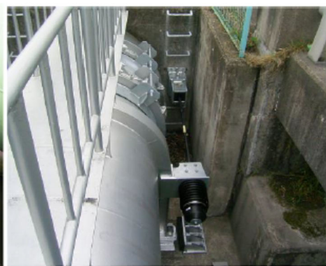
図-7.4.26 伸縮管と移動制限装置
