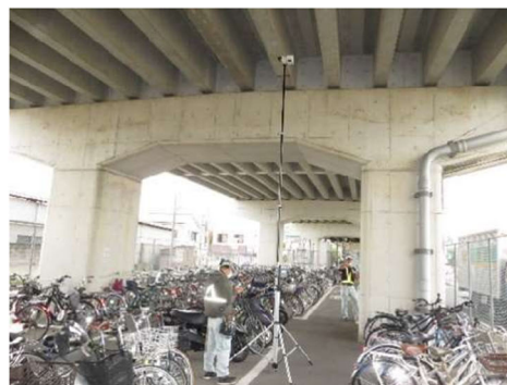
(ロボットカメラ点検)
