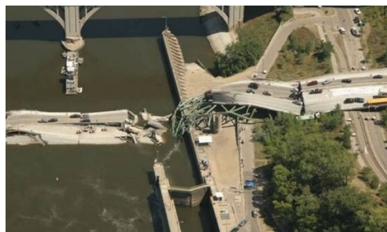
（ミネアポリス I-35W 橋 崩落状況）
