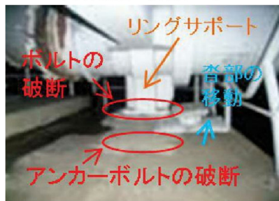
(c) 上沓とリングサポート下端及び下沓でのボルト破断 (P-1)
