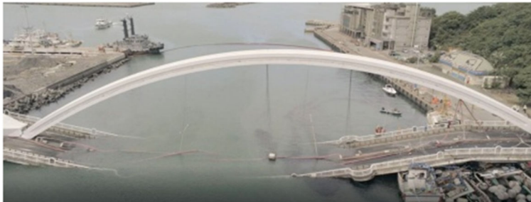
（南方澳跨港大橋 崩落状況）
