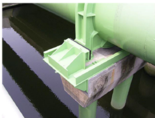
図-7.4.25 移動制限装置
