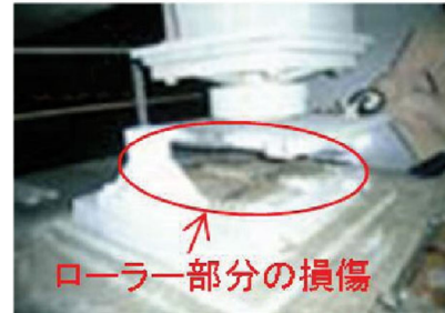
(b) 上沓と下沓の間で破損 (P-3)
