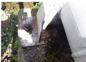
リングサポート固定部の異常 (長孔の閉塞による可動不良)
