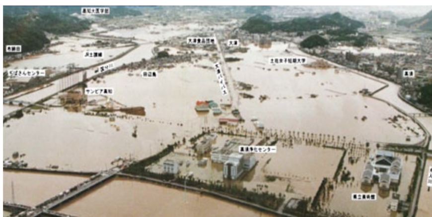
'98豪雨による浸水状況
