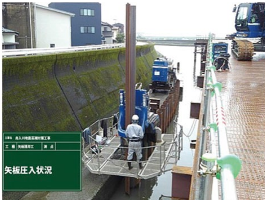
矢板打設状況(舟入川において)
