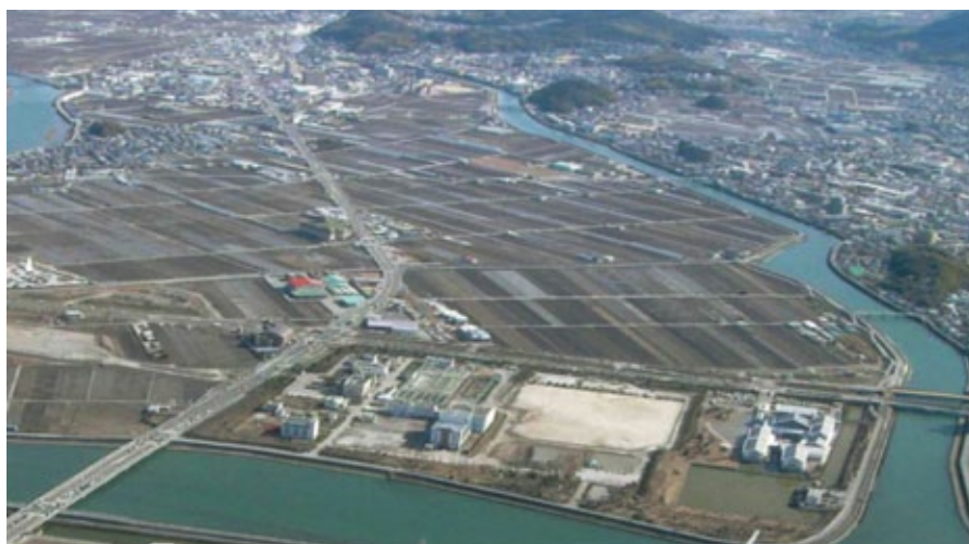
激甚災害対策特別緊急事業完成時
