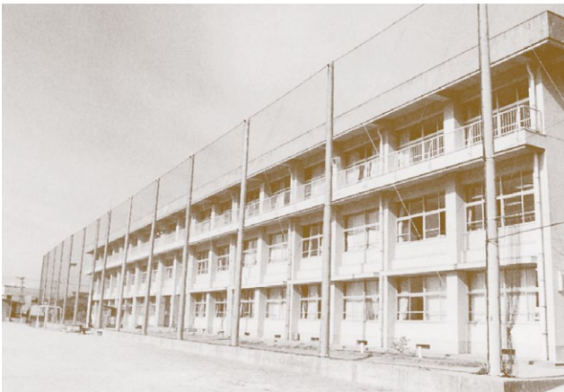
現在地に移転された介良小学校南舎
