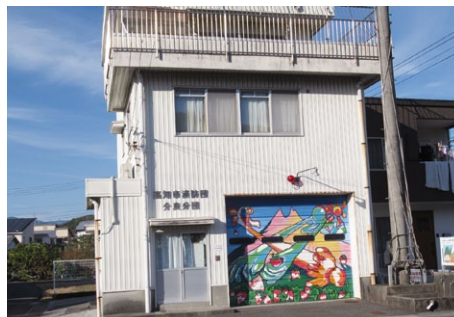
消防介良分団屯所
