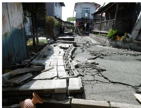
ブロック塀の倒壊の様子
