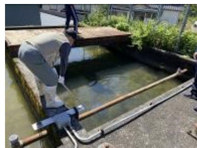
▲飲料水供給施設整備 (緑ヶ丘団地専用水道)
