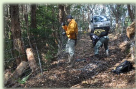
▲有害鳥獣防止柵 保守点検
