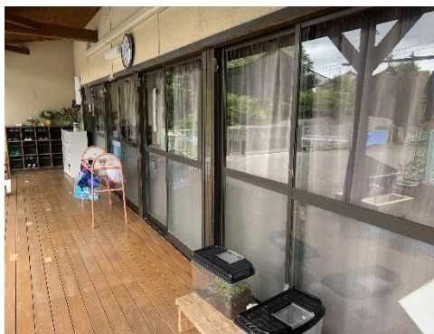
②テラス：窓ガラスに割れはないか確認
