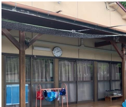
③天井：照明などの落下物がないか確認
